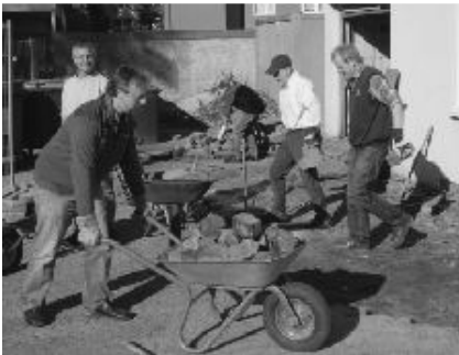
Beginn der Bauarbeiten Foto: Kamien
